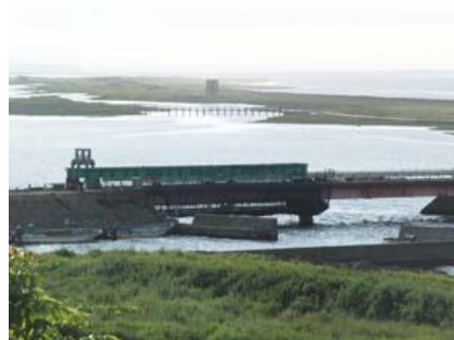
工事中の春国岱橋
